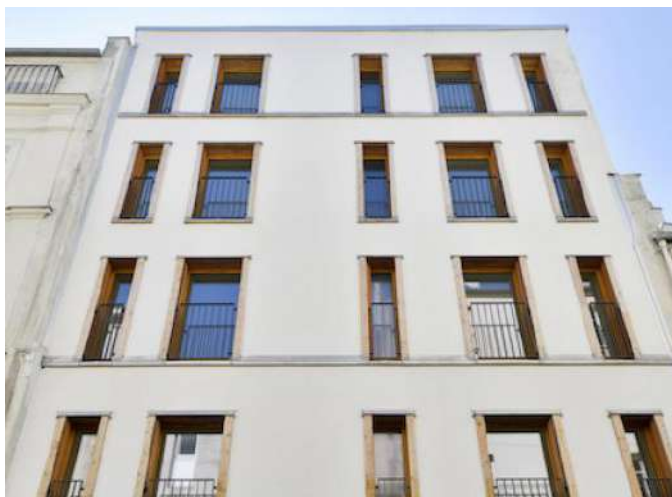
Exemple d'un bâtiment en briques de chanvre à Paris
