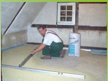
▪ Balance pouring (Ausgleichsschüttung)
